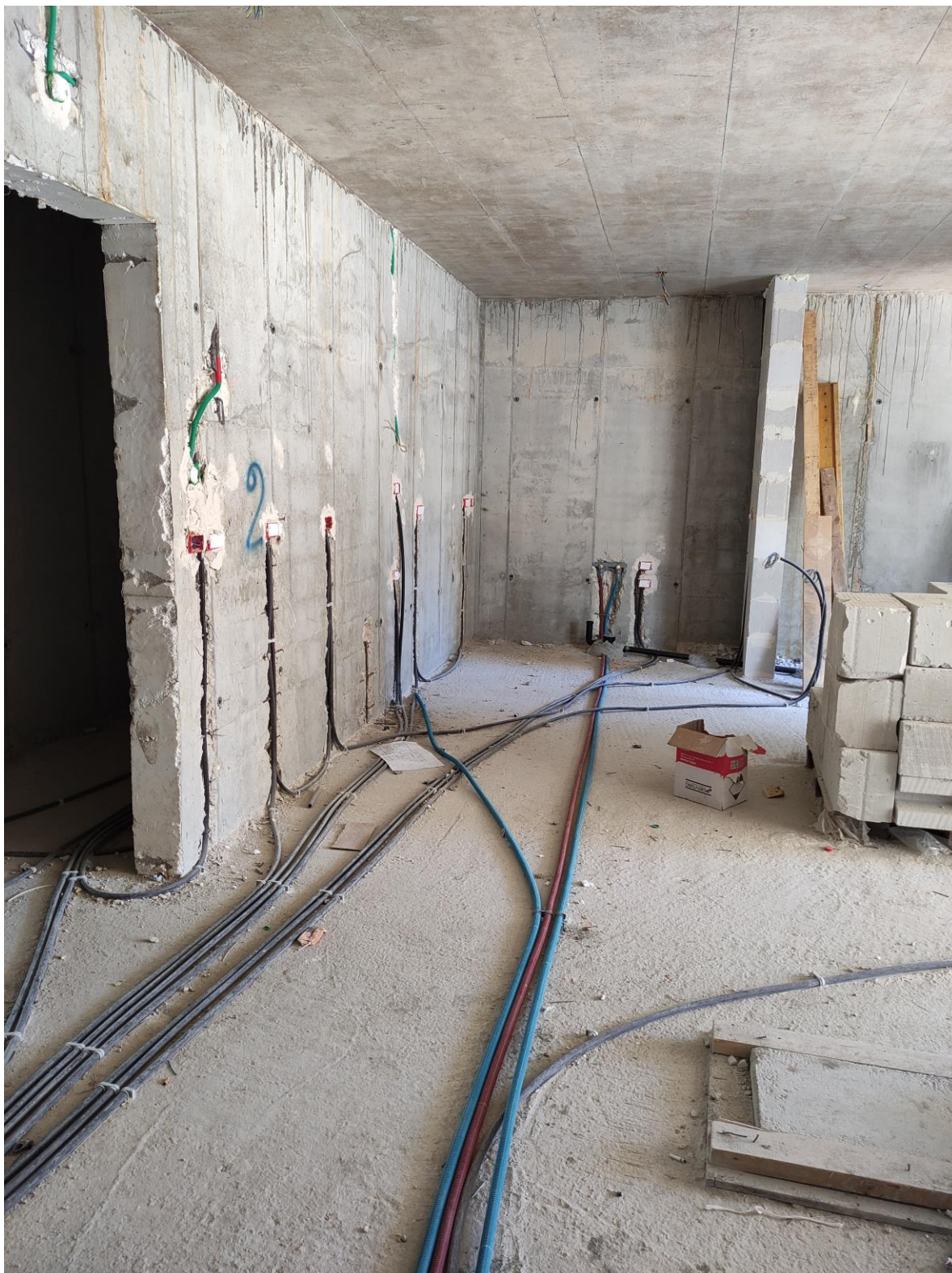
דירה 2 - קומת קרקע – עבודות חשמל ואינסטלציה לאחר ביצוע קירות פנים
